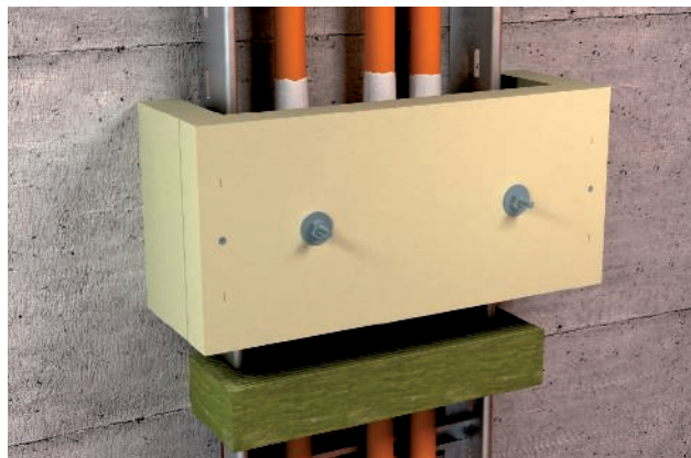
Sisestage alumine mineraalkiudplaat.
